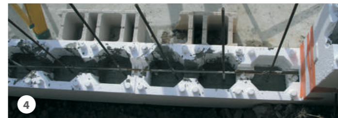
4 Coulage des parois : Le remplissage des blocs doit être réalisé progressivement sur tout le périmètre de la piscine.
