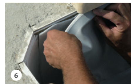
6 Pose du feutre et du liner : Ils assurent le confort et l'étanchéité de la piscine. Veillez à toujours poser votre liner sous aspiration d'air pour éviter les plis.
