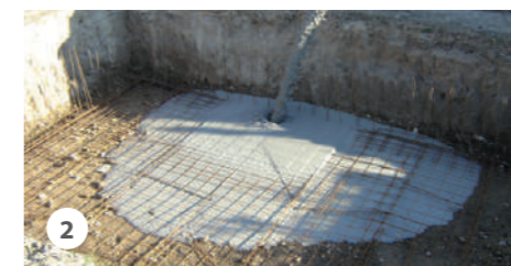
2 Coulage du radier : Coulez la dalle avec du béton dosé à 350 kg/m³ (norme B25)
