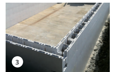
3 Montage des blocs : Les blocs seront emboîtés les uns dans les autres grâce à leurs tétons.
