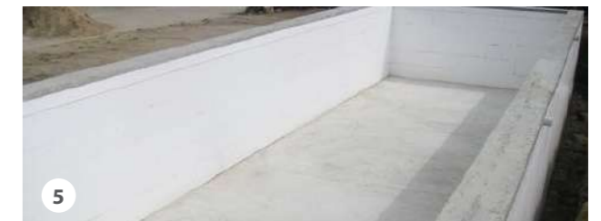
5 Arasement des parois : Il permettra de recevoir le profil d'accrochage du liner ainsi que les margelles.
