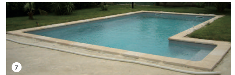
7 Mise en eau : Remplissez la piscine et mettez en place les brides d'étanchéité des pièces à sceller.
